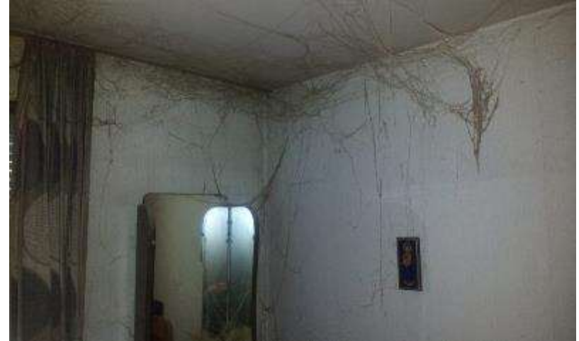
Abb. 17 / Spinnennetze in einer Messie-Wohnung Foto: tuttifix gmbh / 2012
